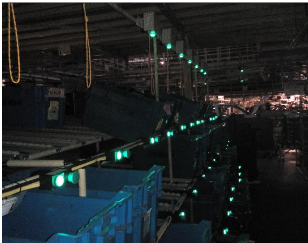
Policový systém vybavený ASi riadenými tlačidlovými svietidlami a svietidlami s ťahacím spínačom
