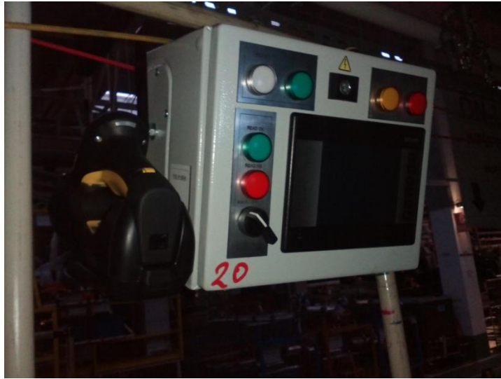
DCT PICKUP vezérlőszekrény
