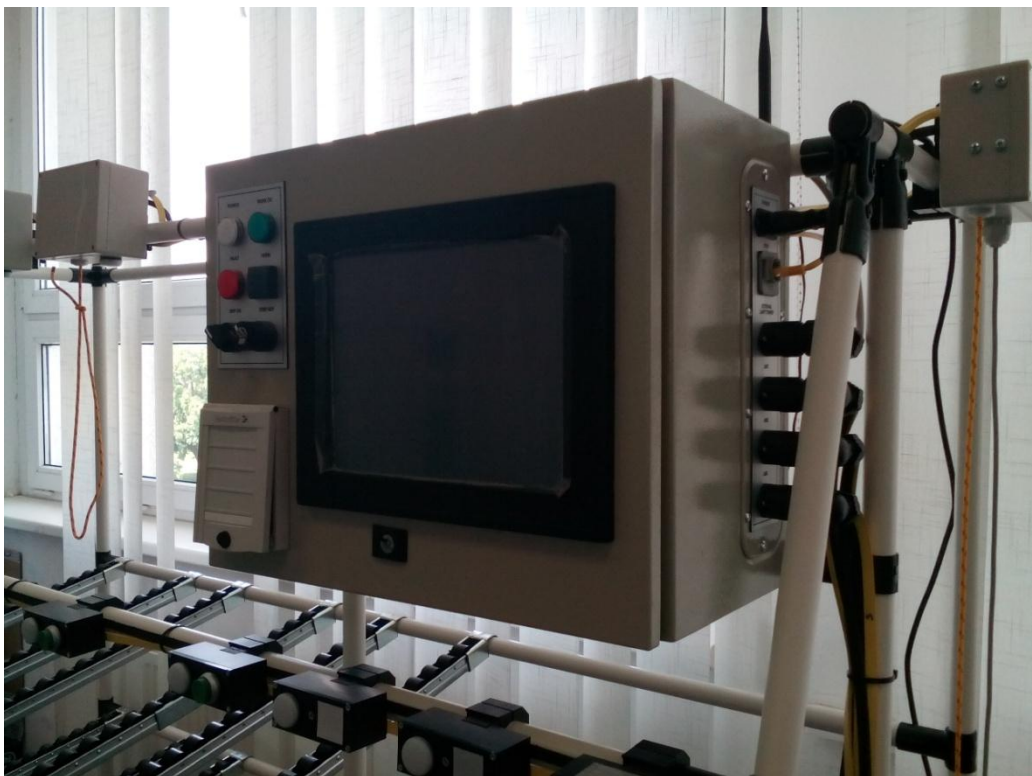
ASi Masterekkel felszerelt vezérlőszekrény
